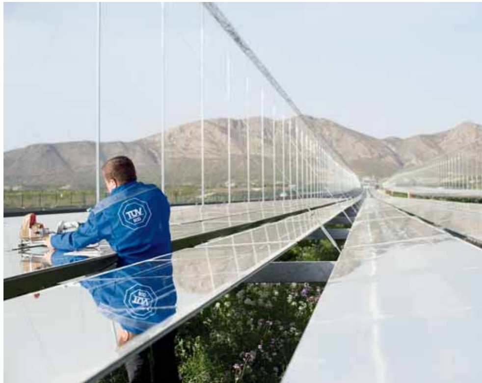
Flaches Glas statt Parabolspiegel: Die Fresnel-Technologie schafft klare Kostenvorteile.
